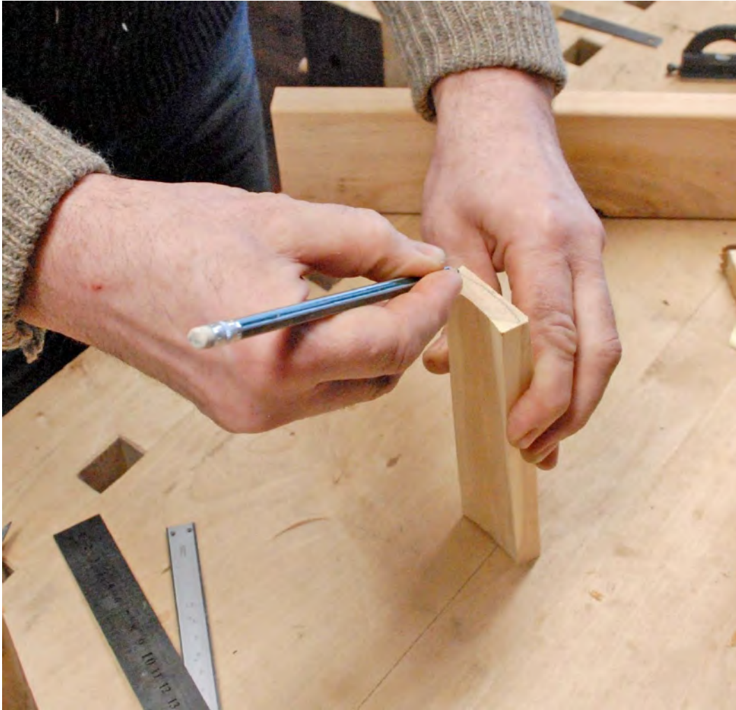
Joonis 5. Laua väliskülje märkimine.
